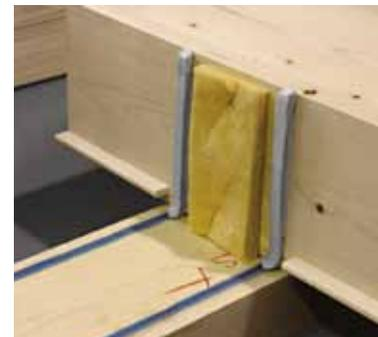
I nastri di tenuta all'aria verticali nei dettagli dell'appoggio devono essere montati sul posto. I dettagli, come indicato a sinistra, sono stati verificati presso l'ift Rosenheim, sono comprovati e hanno già superato con successo diversi test blower door.
