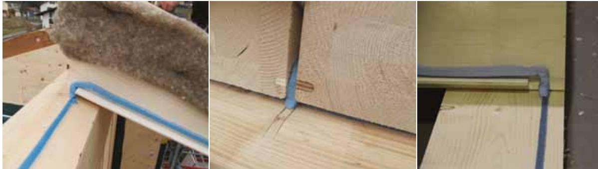
Un nastro di tenuta all'aria assicura l'ermeticità duratura delle fughe fra gli elementi. Entrambi i lati sono adesivi e offre la massima aderenza, resistenza all'invecchiamento e adattabilità. Su richiesta viene interrotto in corrispondenza dell'appoggio il giunto maschio-femmina. Il capo del nastro di tenuta all'aria deve essere quindi steso sulla banchina.
