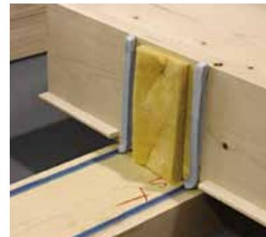
Vertikale Luftdichtungsbänder bei den Auflagerdetails sind bauseits anzubringen. Die Details, wie links gezeigt, wurden am ift Rosenheim geprüft, sind erprobt und haben schon diverse Blowerdoorprüfungen erfolgreich bestanden.
