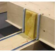
Une bande d'étanchéité dans les joints, sous forme d'un ruban adhésif double face, est prévue pour assurer une étanchéité à l'air parfaite et durable entre les caissons. Sur demande, nous interrompons les languettes sur l'appui du caisson et jointons à la colle. L'extrémité de la bande d'étanchéité à l'air doit être comprimée sur la lisse d'appui.
