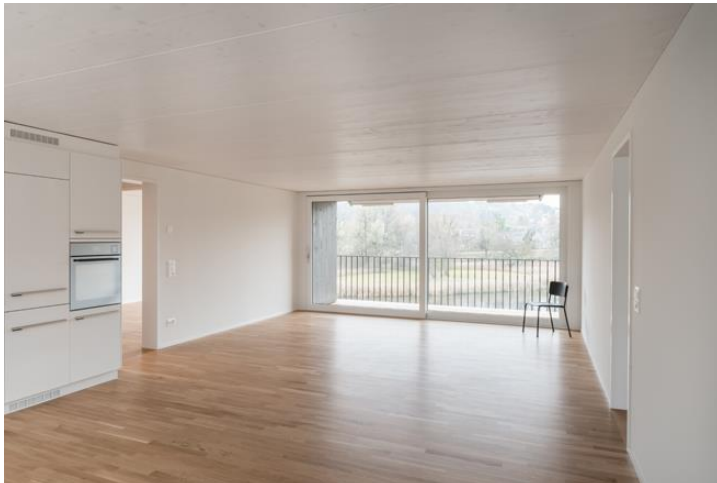
Foto: TFO_6450-Pano Die Lignatur silence12-Elemente mit einer Bauhöhe von 180 Millimetern wurden im EG sowie im 1. und 2. OG weiß lasiert.
