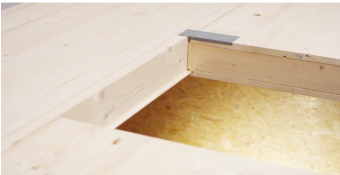
Grosse Auswechslung mit Wechsel und Wechselblech
