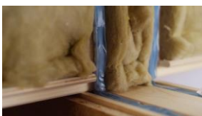
Luft- und Winddichtung an Wand anschliessen
