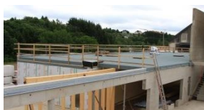
Anschluss an andere Gewerke
