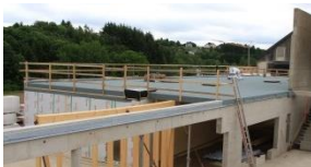
Anschluss an andere Gewerke
