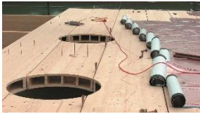
Kaltselbstklebebahn mit variabler Nahtverklebung
