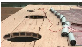
Kaltselbstklebebahn mit variabler Nahtverklebung
