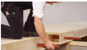
Stahlrohre setzen
