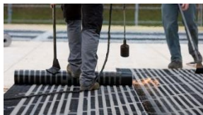
Kaltselbstklebebahn mit variabler Nahtverklebung
